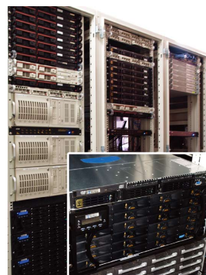
研究所に導入されたぶらっとホームのオリジナルストレージとオリジナルサーバー
